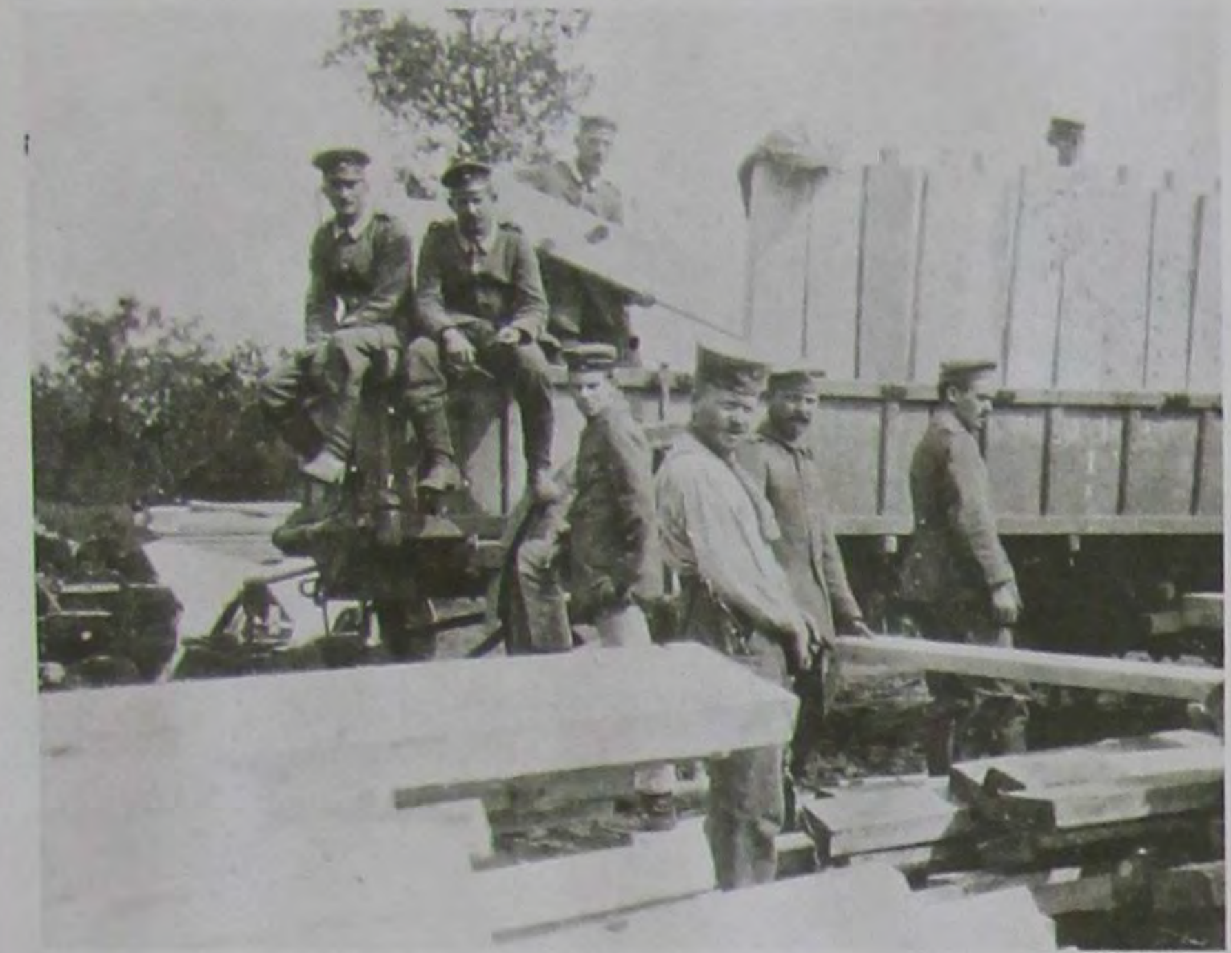
Arbeiten am Bau der Dreieichbahn
