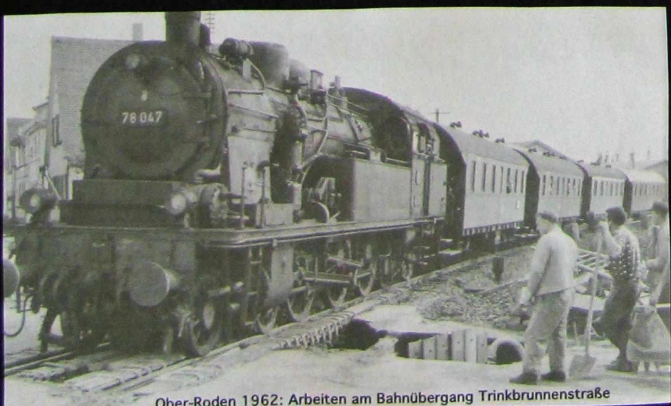
Ober-Roden 1962: Arbeiten am Bahnübergang Trinkbrunnenstraße
