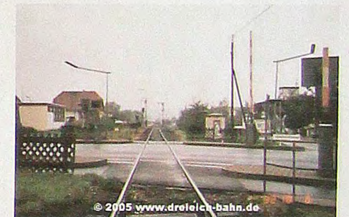
Der Bahnübergang in Urberach erhielt erst 1934 eine Schrankenanlage, nachdem die Streckengeschwindigkeit auf 50 km/h erhöht worden war.
