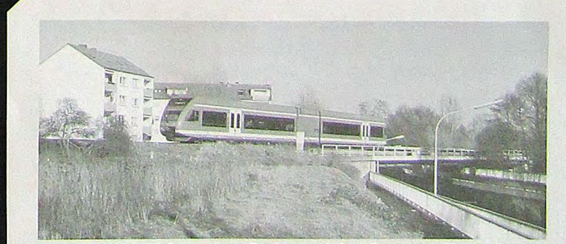
Kurz vor Urberach findet sich heute die einzige Eisenbahnbrücke der Dreieichbahn. Sie entstand 1982 mit der Freigabe der Rodaustraße.
