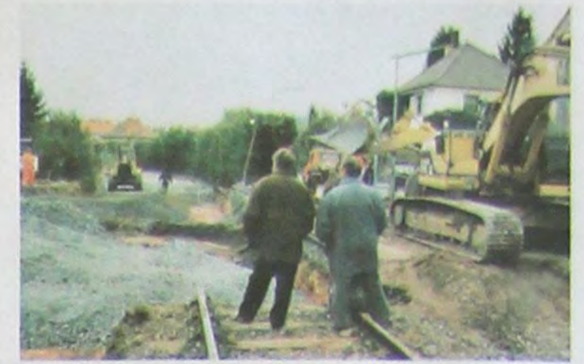
Gleisarbeiten in Urberach
