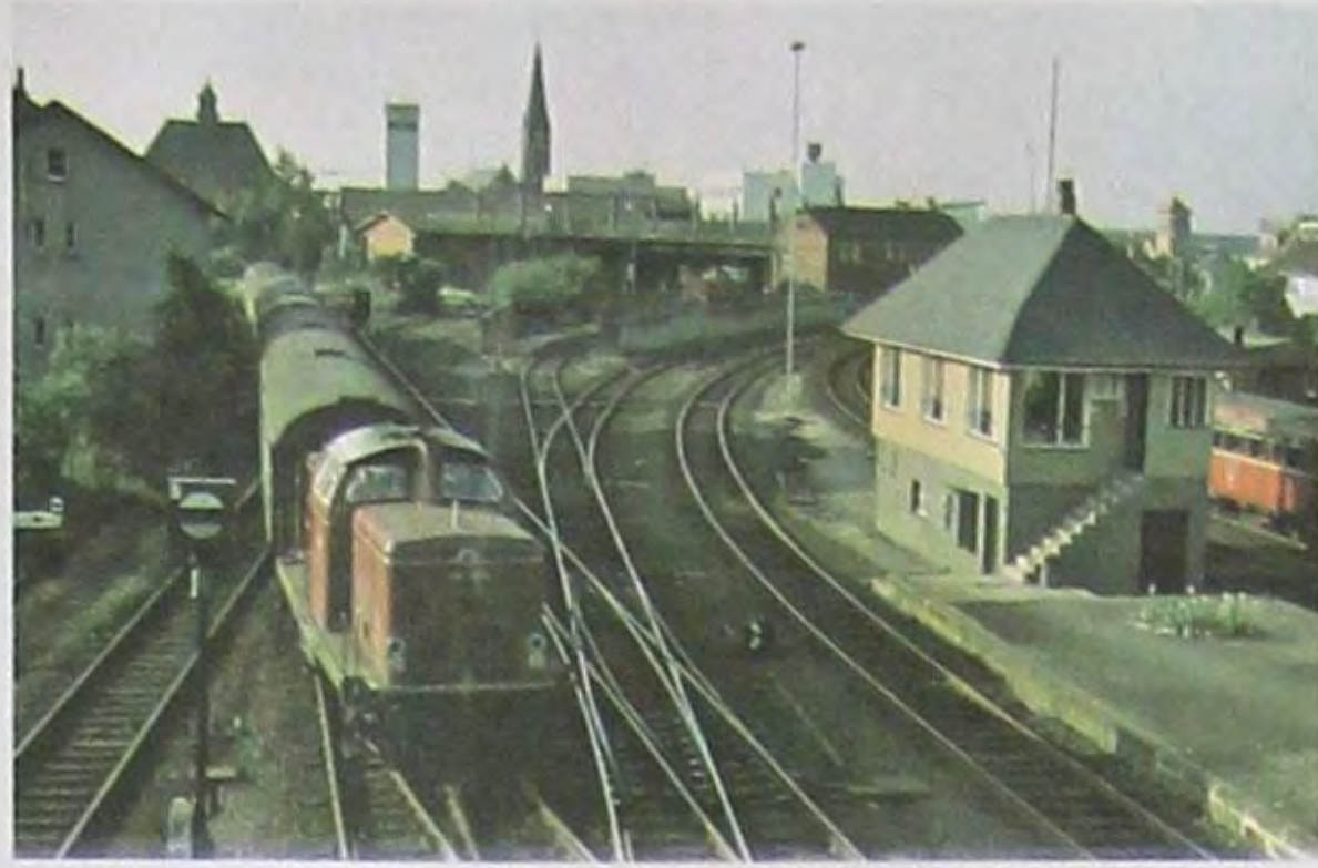
Stellwerk Ober-Roden Nord (On), ab 1945 Sitz der Fahrdienstleitung (Of) - Aufnahme 1977
