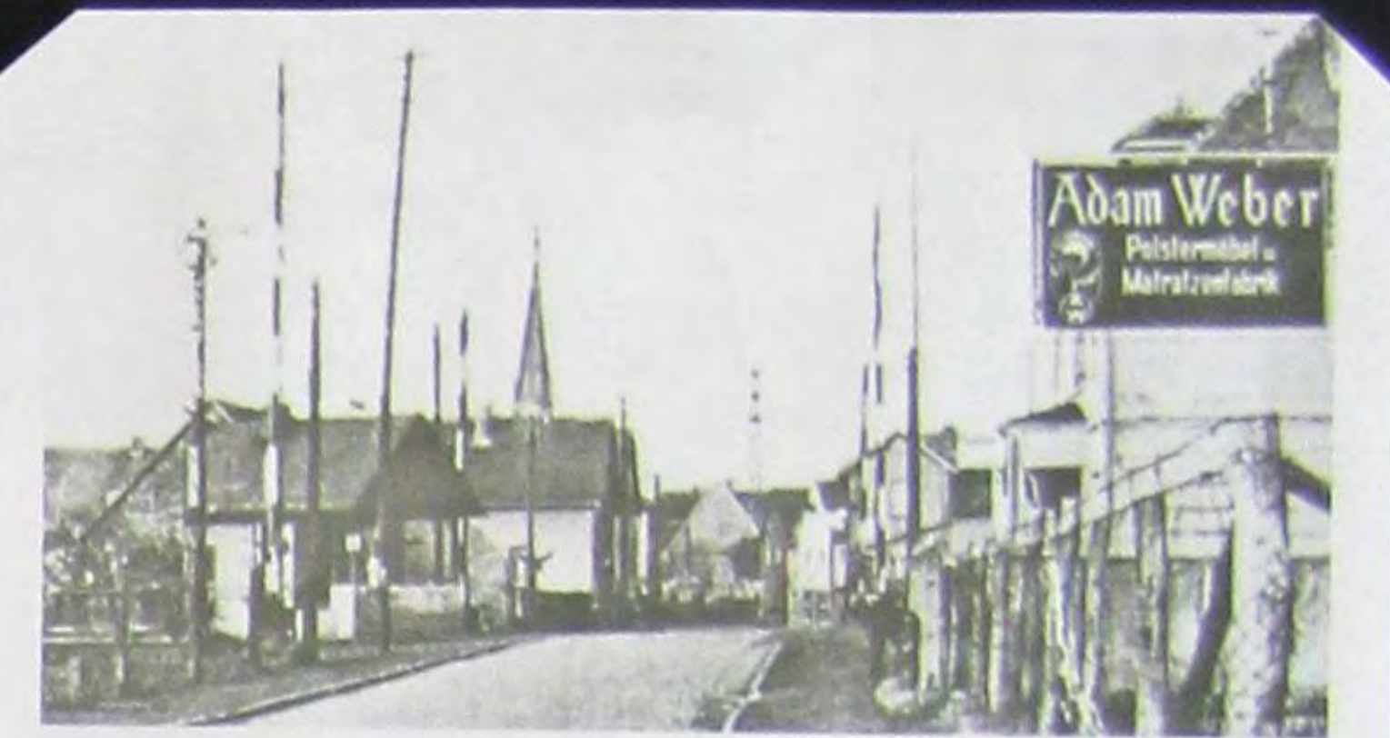
Blick zum Bahnübergang Richtung Dieburger Straße. Links ist das Bahnwärterhaus zu erkennen. Um 1940.
